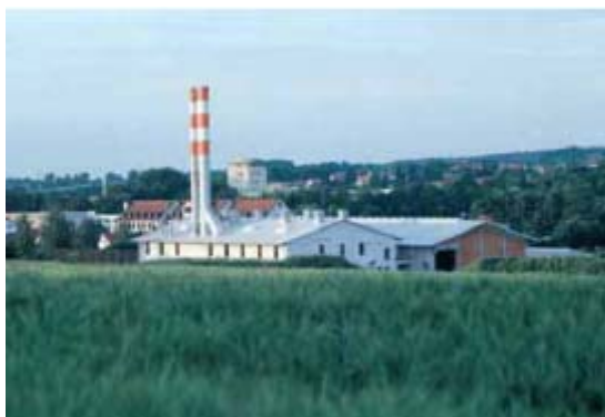
Värmekraftverket för biomassa i Pfaffenhofen: Den tillhandahåller miljövänlig elektricitet, ånga, fjärrvärme och kylenergi.
